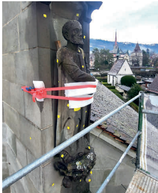
Die Figur Bruder Klaus wurde in einem ersten Schritt mit Spanngurten fixiert (Foto: zVg).
